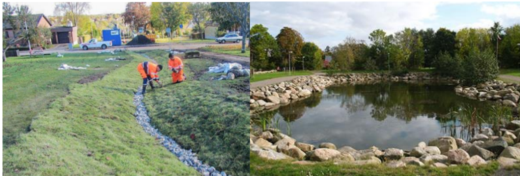
Figur 13. Till vänster svackdike, till höger damm.
