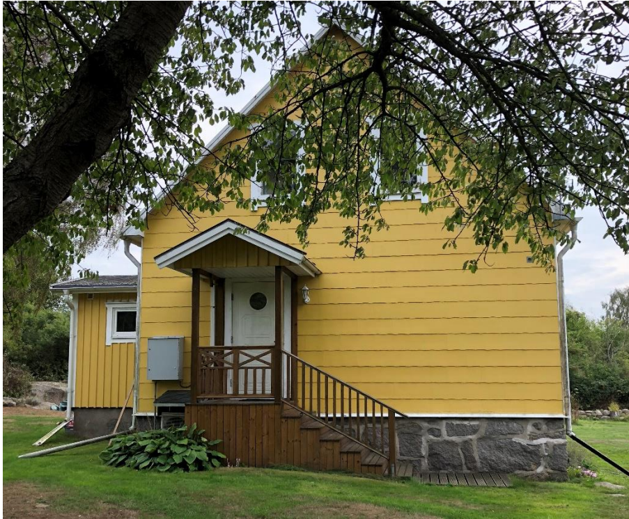
Figur 7. Villa på Hanö, foto taget av Sigma Civil i samband med inventering.
