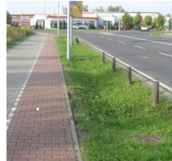
Figur 14- Principskiss av infiltrationsstråk samt ett exempel på ett infiltrationsstråk i en gatumiljö (Stockholmvattenochavfall, 2023).
