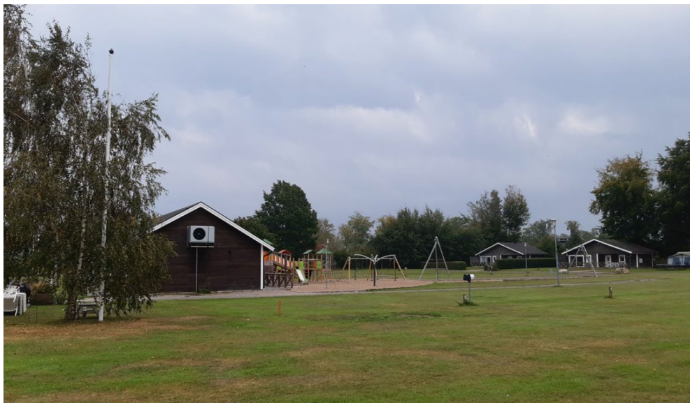
Befintlig servicebyggnad och lekplats centralt inom planområdet.
