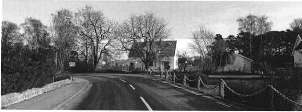
Vy från sydväst via Strandvägen över fastighet Hörby 45:4 med f.d. stationshus
