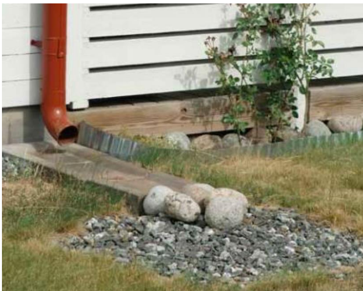
Figur 9: Stuprörutkastare med rännalsplattor med erosionsskydd som leder ut vattnet på gräsmatta.
